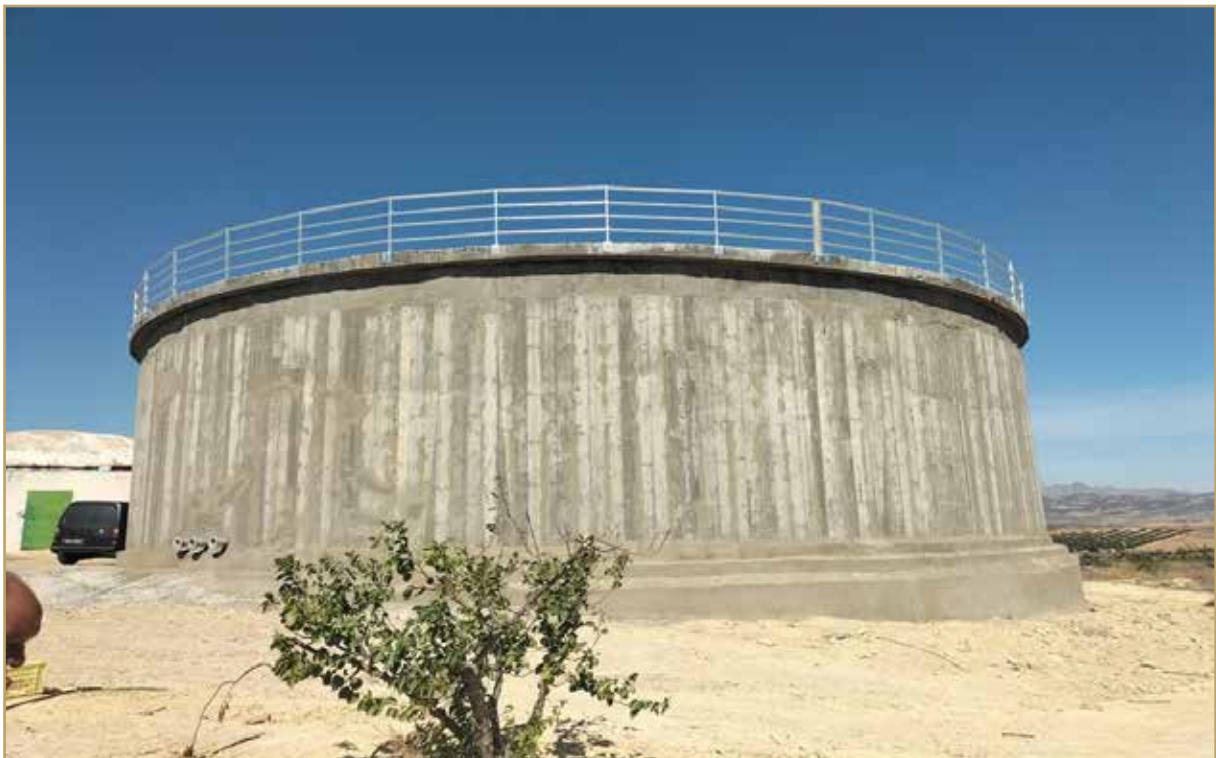
Projet Bâche à eau en béton 1000 m 3 - en construction à Zaghouan
