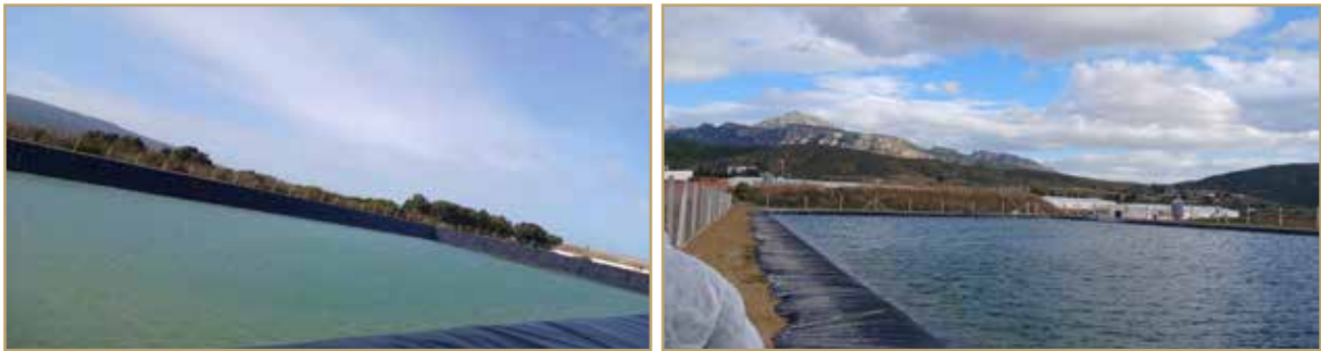
Bassins à ciel ouvert 20 000 et 10 000 m 3 - construits à Haouaria et Zaghouan
